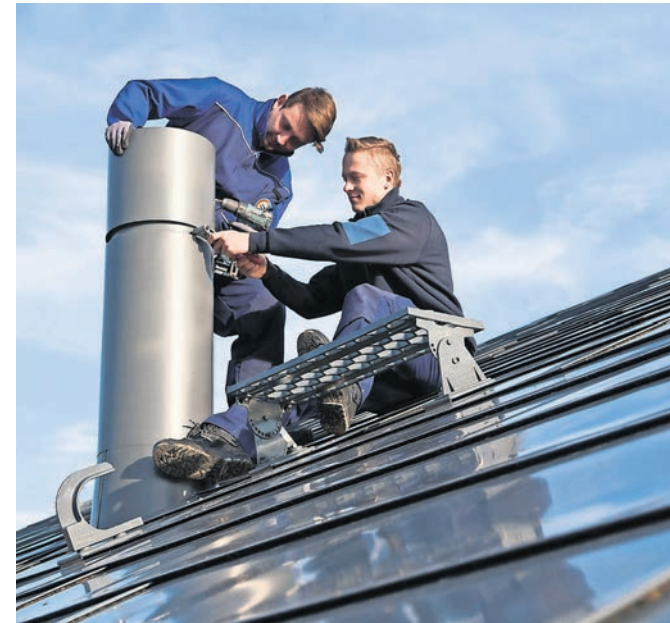
Was viele nicht wissen: Metaldächer werden von Klempner:innen montiert.
